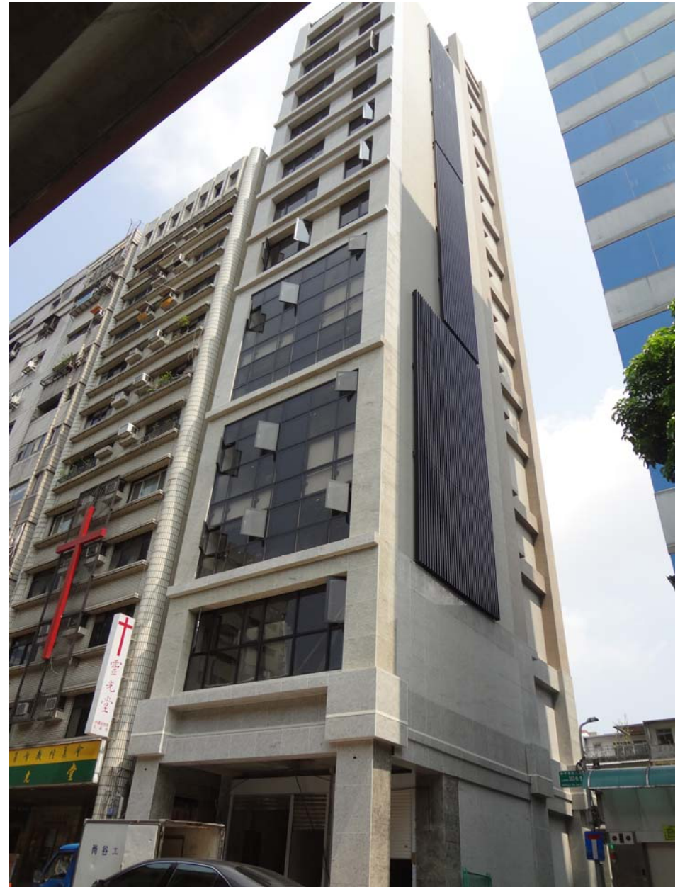
和平東路案正立面現況
