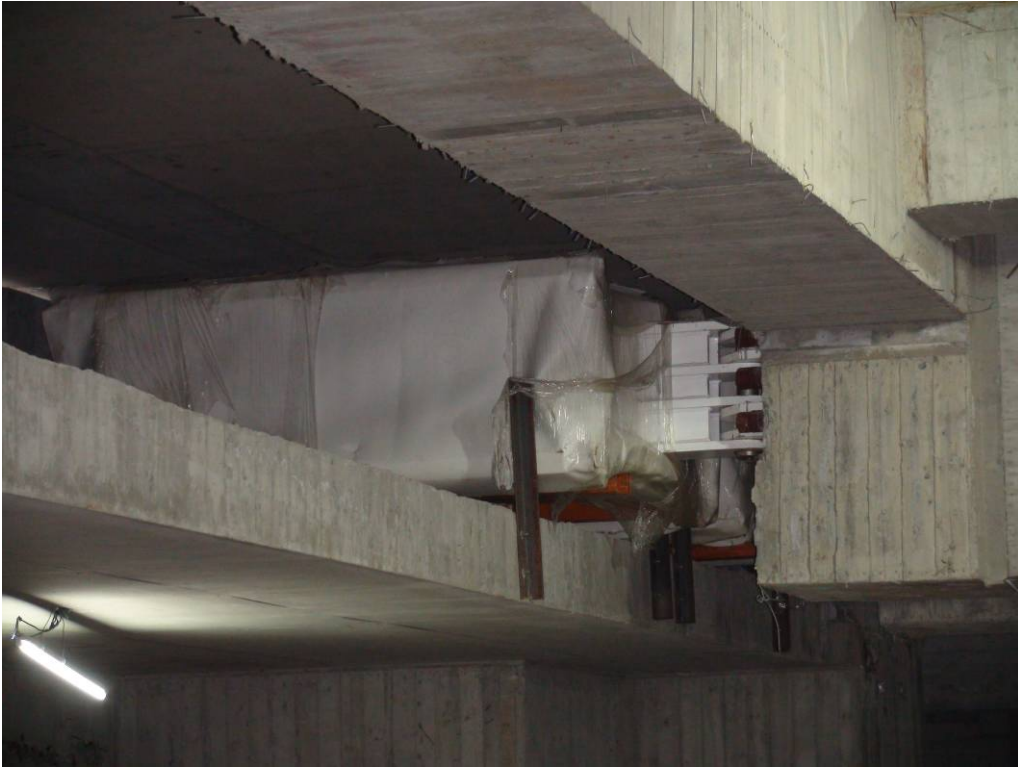
消能器安裝完成後現況
