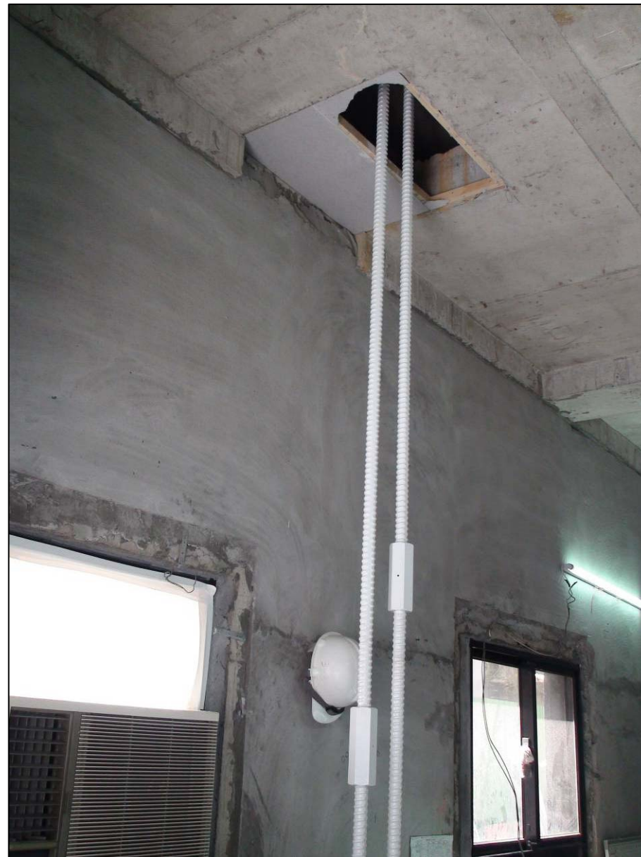
預拉系統安裝現況
