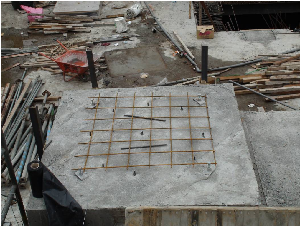
支承墊安裝前柱頭處理
