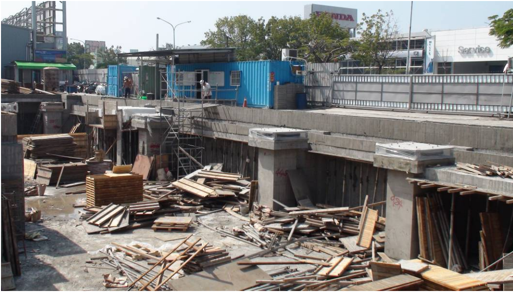
支承墊安裝後現況
