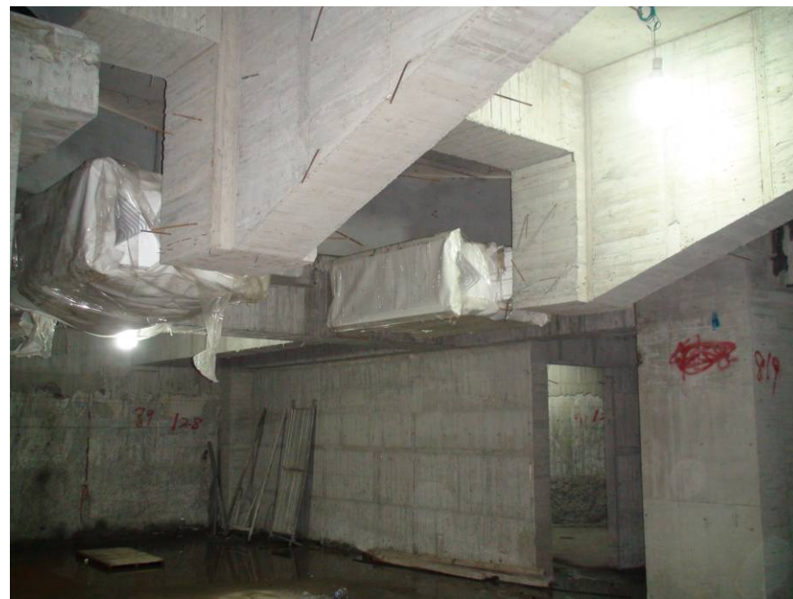
消能器安裝完成後現況
