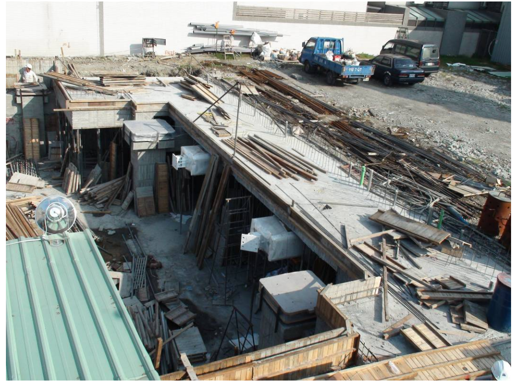
消能器固定於連續壁現況
