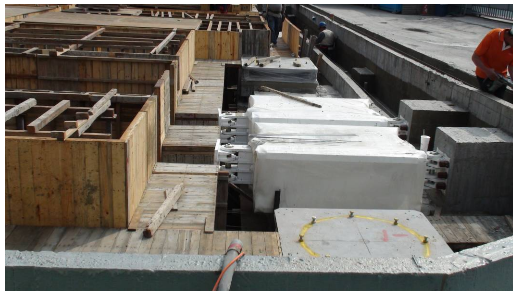
上部結構通過消能器錨定於連續壁
