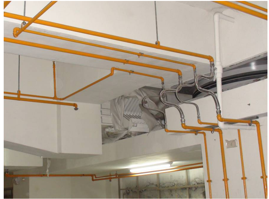
ASBD隔震系統完工現況
