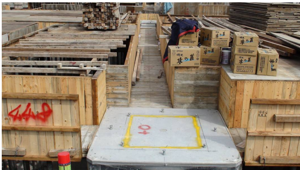
上部結構坐落於支承墊現況
