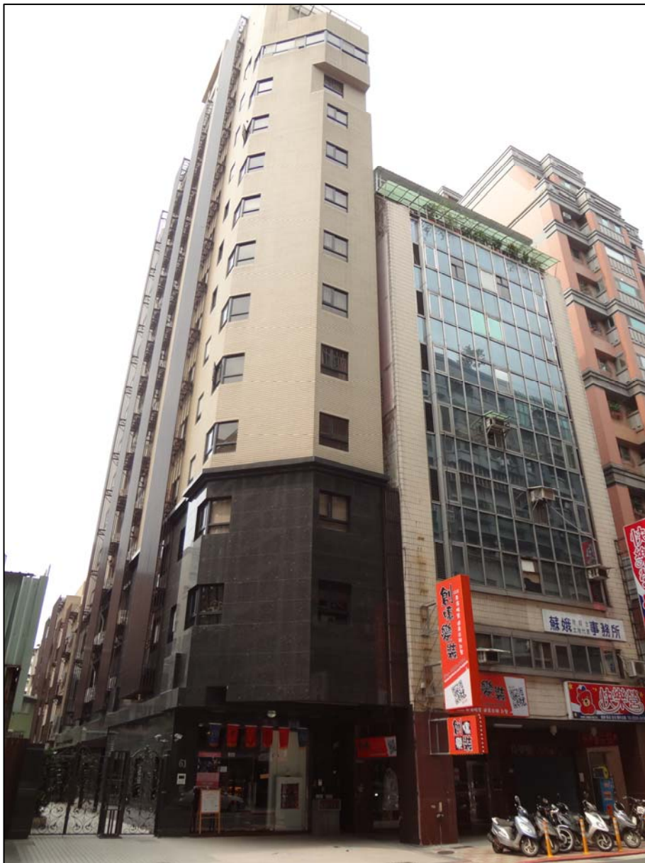
長沙街正立面現況
