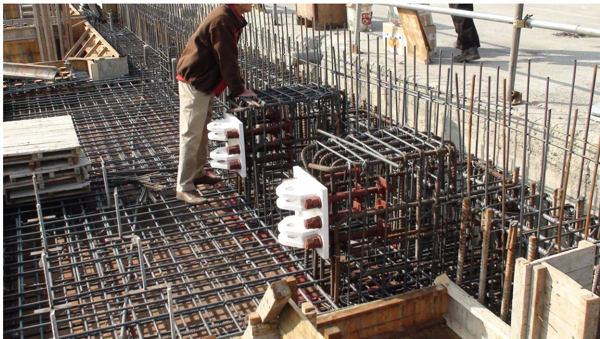
消能器反力座錨定於連續壁之配筋
