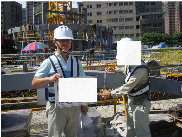
電銲前 開槽角度、組立間隙查驗
