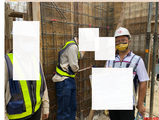
3 角隅補強鋼筋
