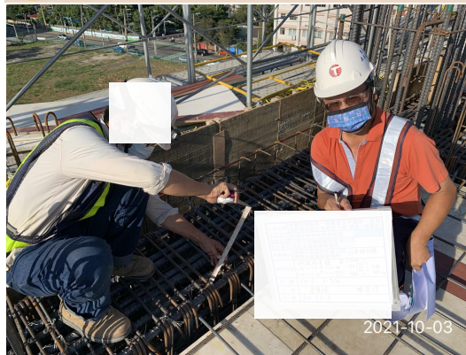
5 主筋90°、箍筋135° 彎鉤長度
