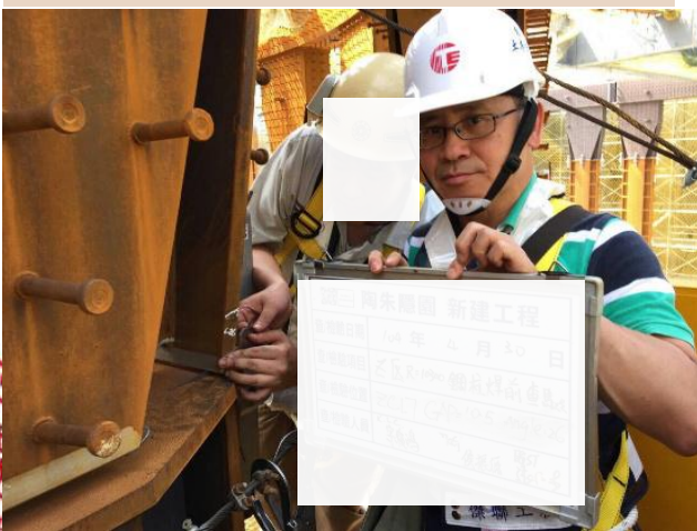
電銲前 開槽角度、組立間隙查驗
