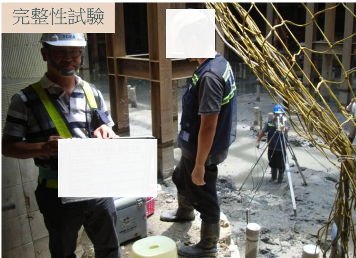
基樁樁底改良灌漿
