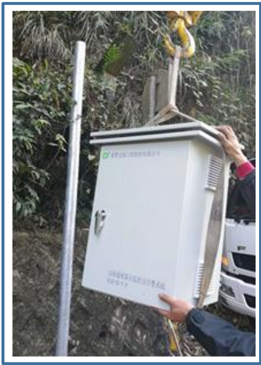
照片 5 安裝公路邊坡落石監控箱
