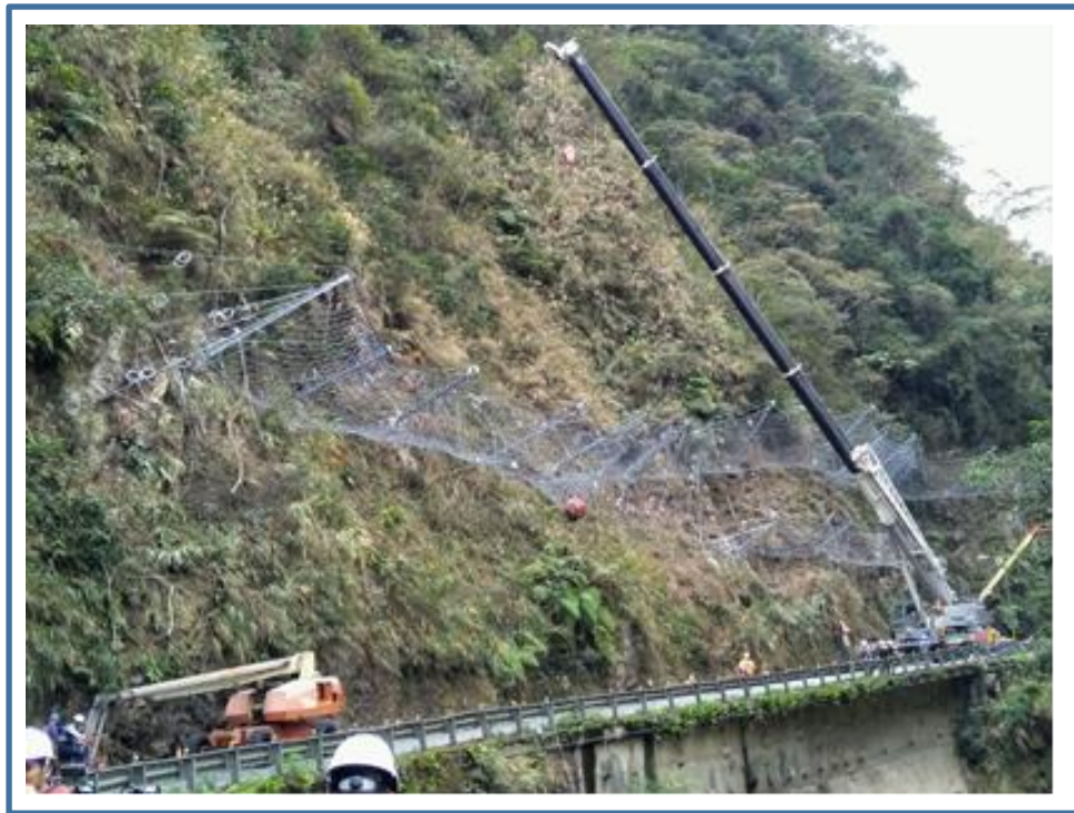
照片 3 模擬落石確實落入且未穿破防護網
