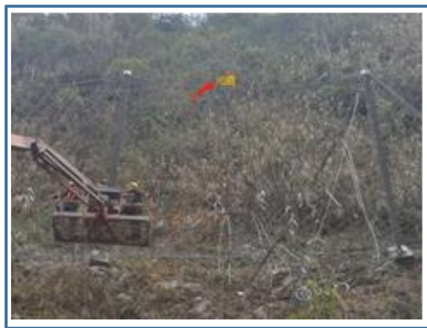
照片 4 架設振動傳感光纜
