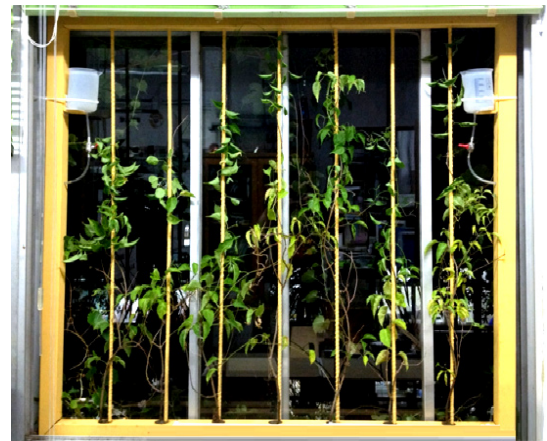
圖 11 GFRP 植生窗框施作完成圖
